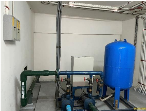
ระบบสูบน้ำขึ้นหลังคา
