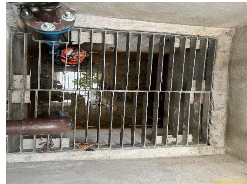
บ่อสูบน้ำขึ้นใต้ดิน
