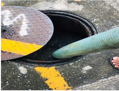
สูบน้ำส่วนเกินระบบบำบัด
